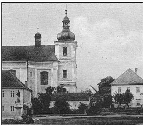
Původní hasičská zbrojnice u kostela
