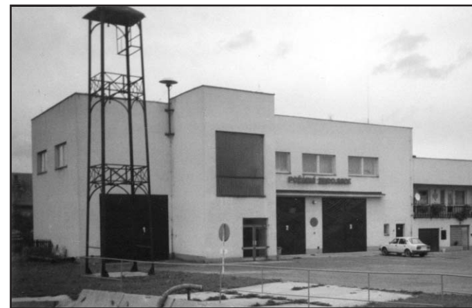
Hasičská zbrojnice postavená v letech 1986 -1988
